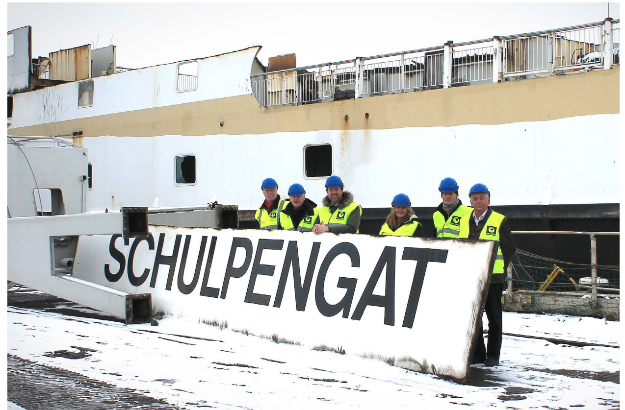
Op 1 februari 2019 bezochten de RvC en de directeur Galloo om een indruk te verkrijgen van het verloop van de sloopwerkzaamheden
