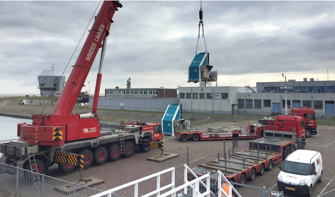
De moormasters werden op 29 januari 2019 van het ponton gehaald ten behoeve van uit te voeren onderhoudswerkzaamheden
