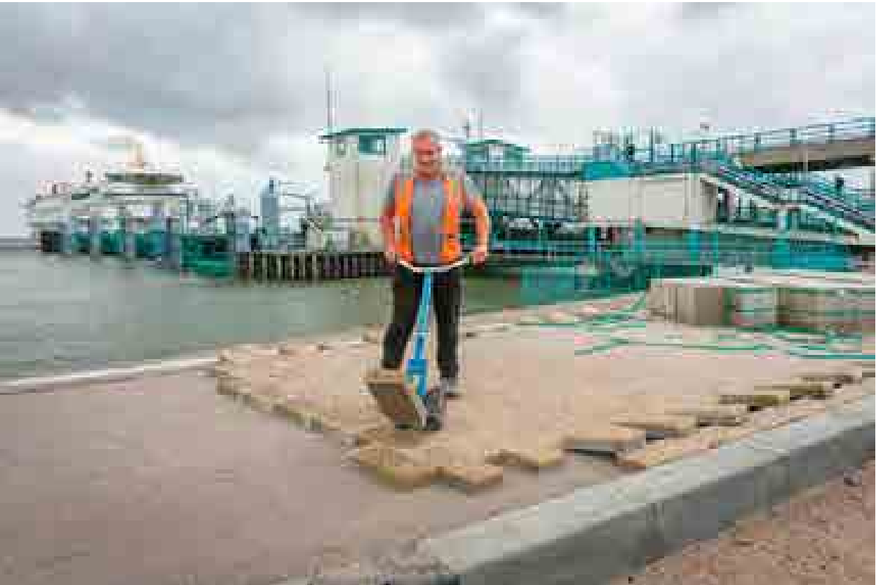
Aanleg van de nieuwe promenade op de Texelse veerhaven
