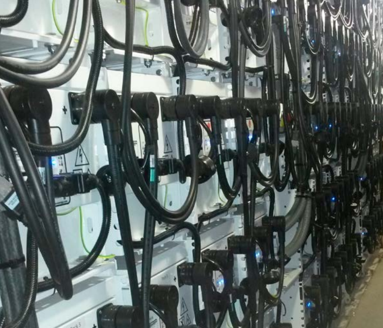
Duurzaam varen met o.a. 1,6 MW batterijen, gebruik restwarmte motoren en 700m 2 zonnepanelen.
